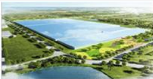
温室设施工程
