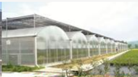
薄膜连栋温室工程
