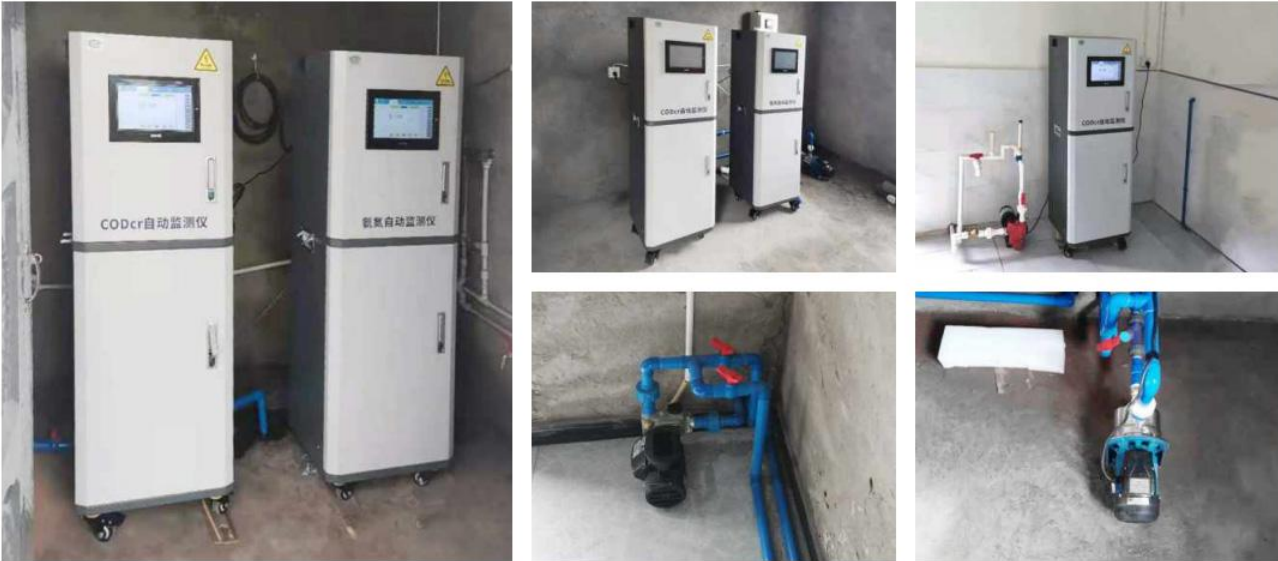
监测参数:pH、COD、氨氮、流量 仪器:OLK-DG150、OLK-G8601、OLK-G8602、GL-MQ-201-C4
