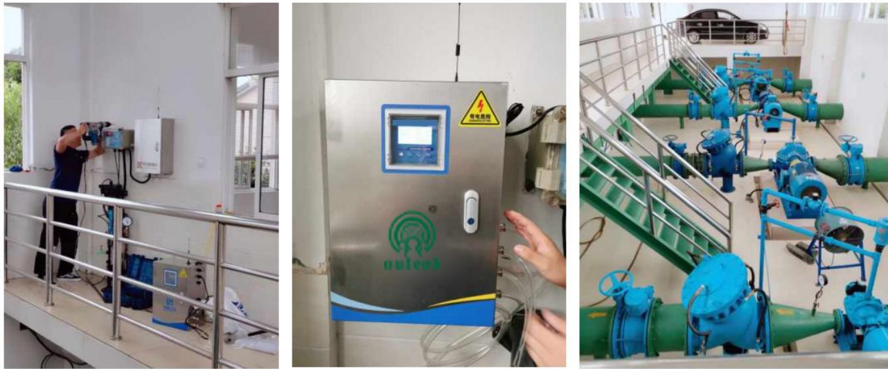
监测参数:余氯、pH、水温 仪器:OLK-G8201在线余氯监测仪
