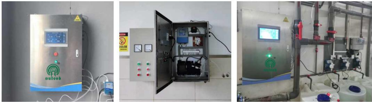
监测参数:余氯、pH、浊度、ORP、水温 仪器:OLK-G8500多参数在线水质监测仪 项目:某连锁酒店水质监测
