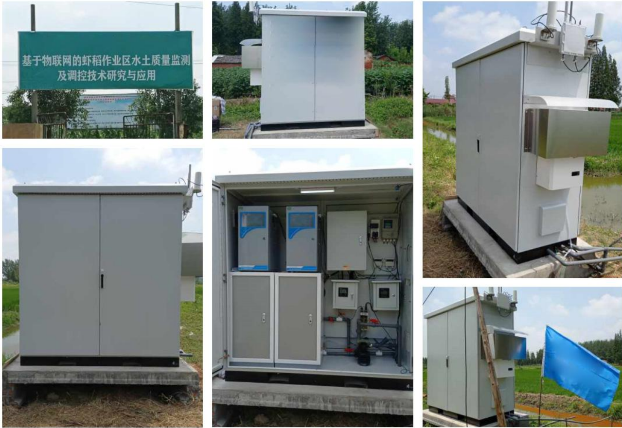
监测参数:企业氨氮、总磷、总氮、pH、流量计监测 仪器:OLK-DG150、OLK-YB08、OLK-G8603、OLK-G8604、户外安装机柜
