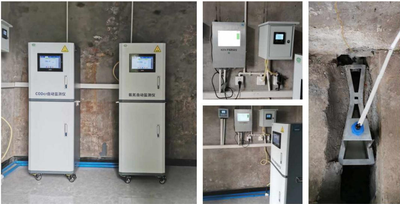
监测参数:pH、COD、氨氮、流量、数据采集 仪器:OLK-DG150、LH-G8601、OLK-G8602、GL-MQ-201-C4、数采仪(K37A)
