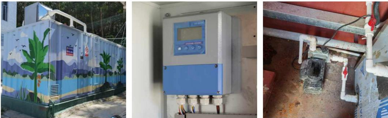
监测参数:余氯、pH、浊度、温度
