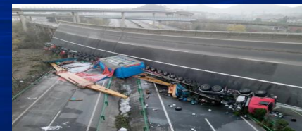
桥梁安全：2021.12.18，湖北鄂州桥面发生坍塌，车辆超载400%运行，导致4人死亡8人受伤。
